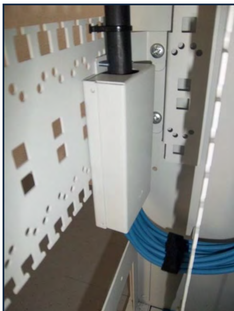
Illustration – Exemple d'équerre d'arrimage du boîtier éclateur
